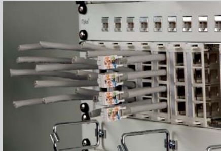
Câblage des guide-fils
