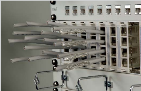
Préparer les câbles
